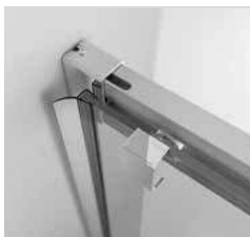
JUNTA DE CIERRE VERSIÓN ENTRE PAREDES
