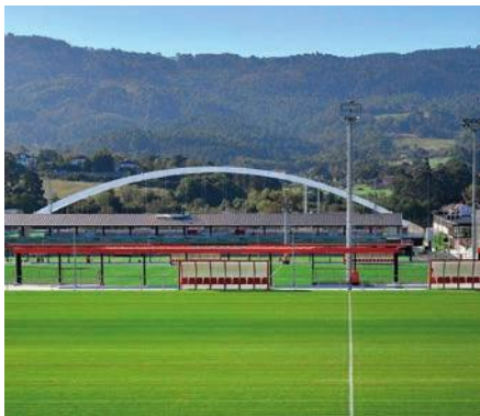
Instalaciones de Lezama Athletic Club (Vizcaya)
