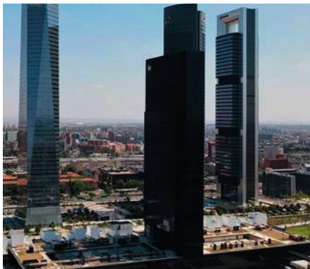
Torre Caleido (Madrid)
