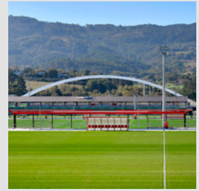
Instalaciones de Lezama Athletic Club
