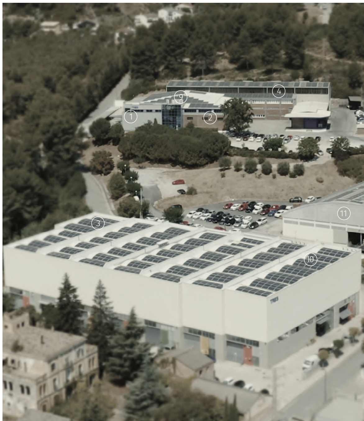
Instalaciones de Tres en Vallirana (Barcelona)
